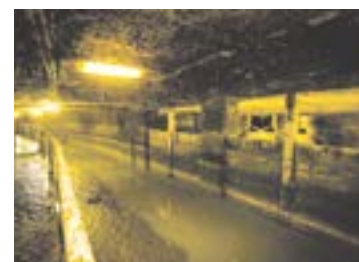
Das Kanalnetz misst 2.500 km.
